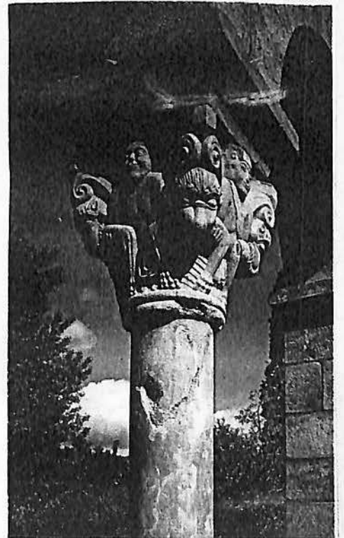
Détail pilier et chapiteau
