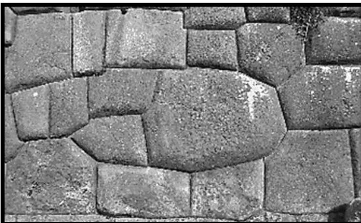
Les pierres s'adaptent si parfaitement qu'aucun brin d'herbe ou de lame d'acier ne peut glisser entre eux. Il n'y a pas de mortier. Les blocs se joignent souvent à des surfaces complexes et irrégulières.
